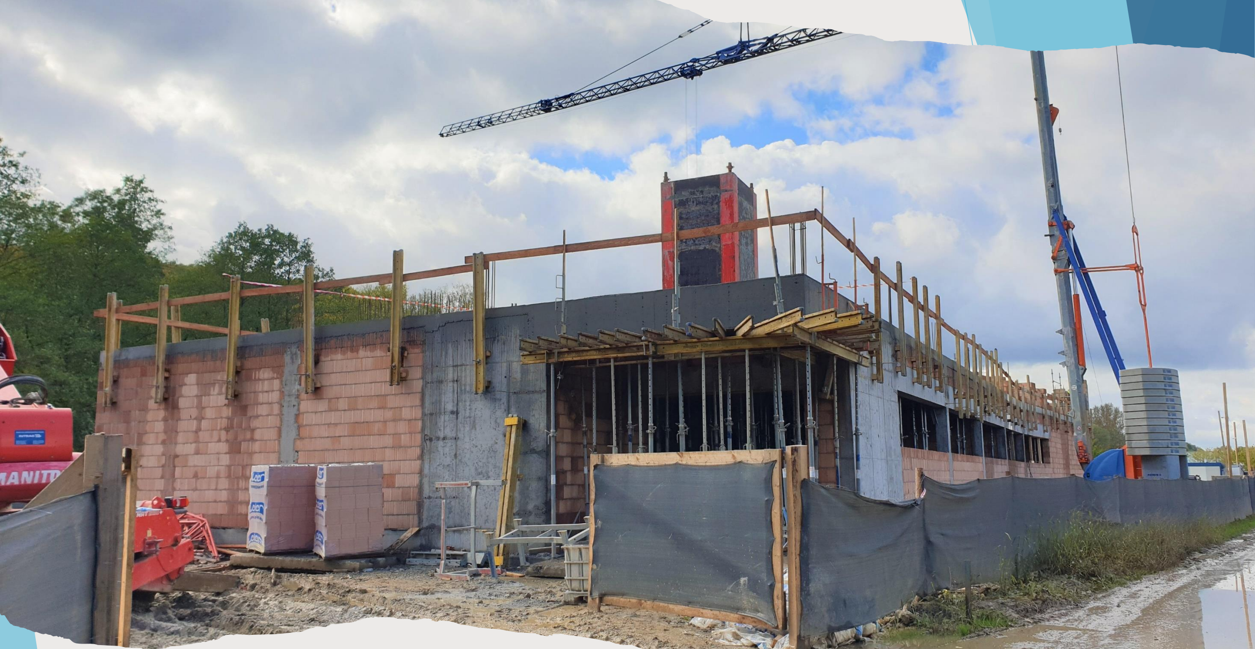
Październik 2022 r. – kondygnacja parteru gotowa
