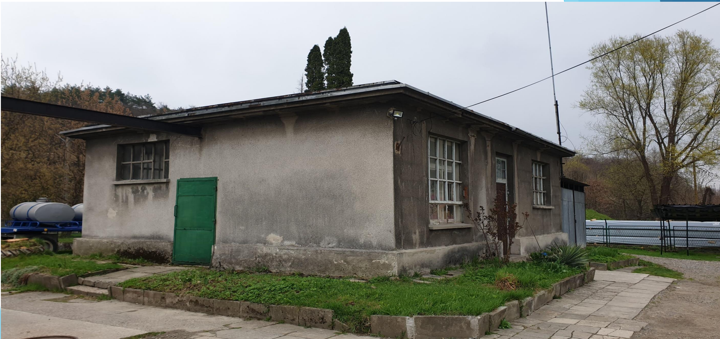
Budynek pompowni wody przed remontem i modernizacją
