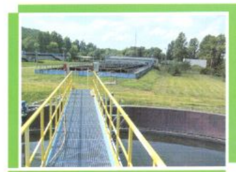
Foto: Oczyszczalnia ścieków w Krzeszowicach
