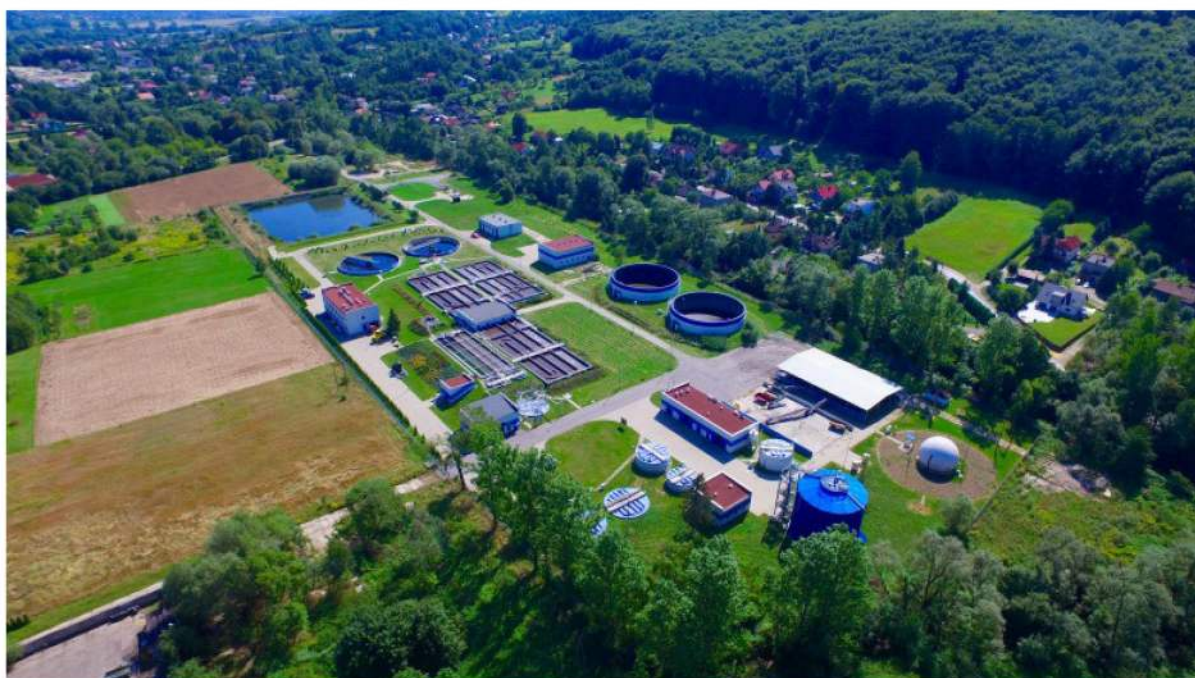
Centralna Oczyszczalnia Ścieków, fot. Wodociągi i Kanalizacja Krzeszowice Sp. z o.o.
